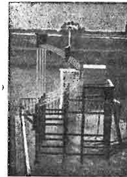
Fig. 5 - Tipo di riflettore Marconi a spina di pesce.
